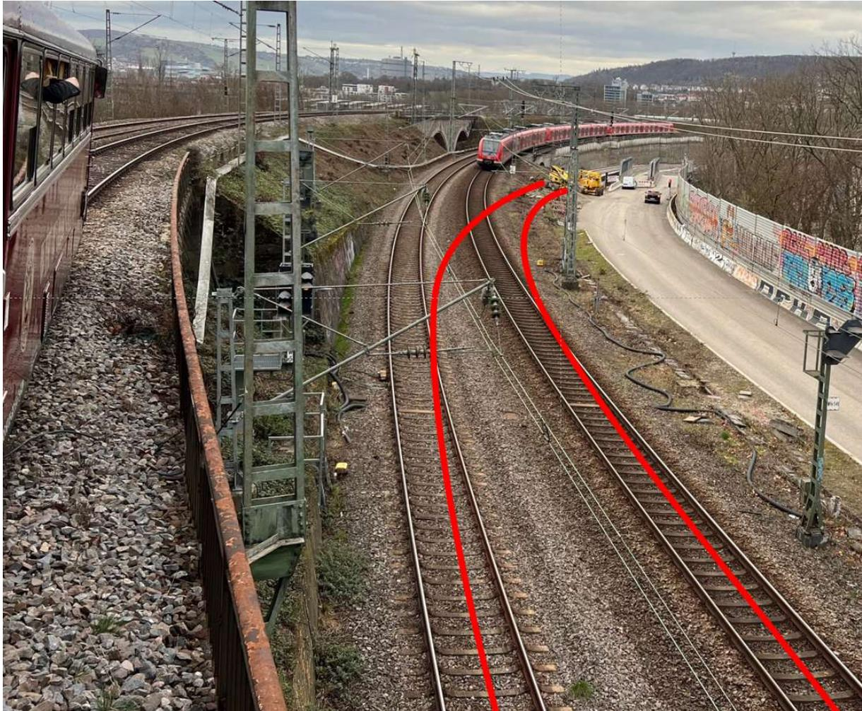
Blick vom Gäubahn-Viadukt in Richtung Hauptbahnhof. Zum Anschluss der neuen Station Mittnachtstraße werden die S-Bahngleise auf die neue Trasse verschwenkt – siehe rote Linien. Ein Konflikt mit der Gäubahn (links im Bild) besteht nicht. Foto: Reinhard König
